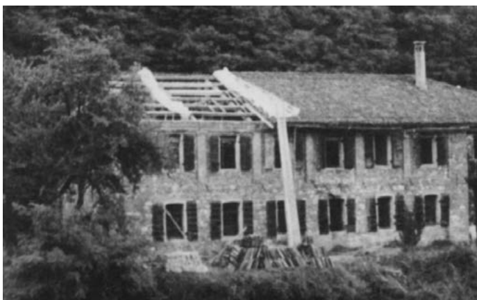
L'edificio in fase di ristrutturazione negli anni 1975-1979
