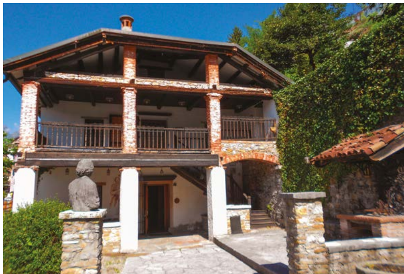
L'ingresso e il ballatoio
